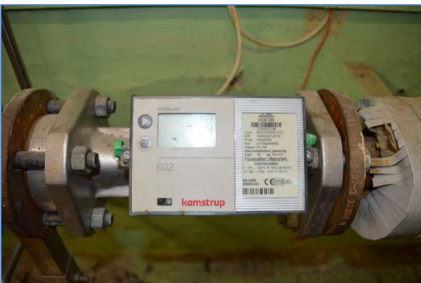
Foto 5: Fjernvarme temperatur fremløb 77C
