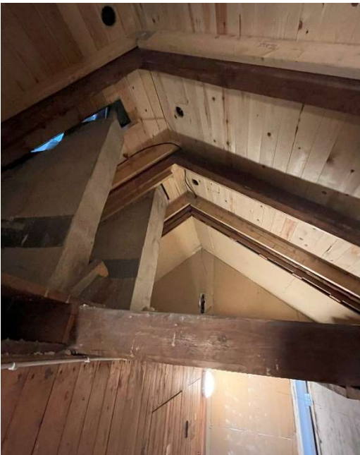
Foto 2: Tag set fra tagrun, med nyt undertag. Udført i rupløjede brædder.
