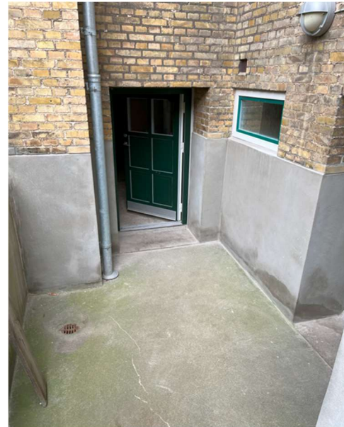
Foto 2: Kældernedgang med nypudset sokkel
