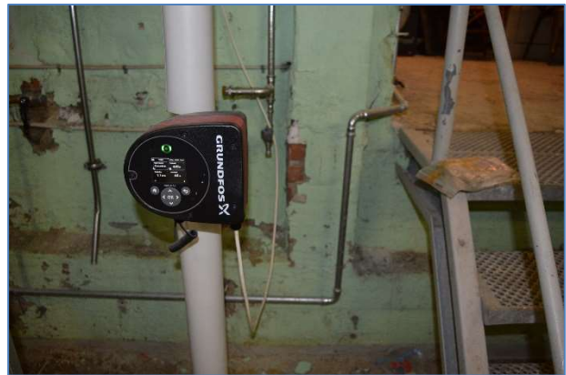
Foto 4: Cirkulationspumpe
