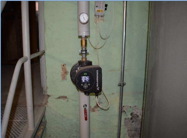
Foto 1: Cirkulationspumpe
