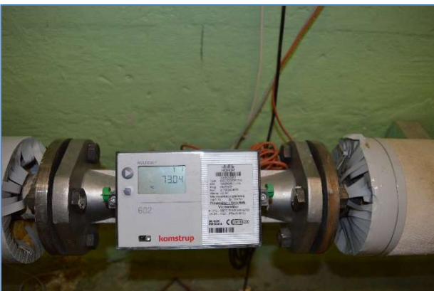
Foto 5: Fjernvarme temperatur fremløb 73C
