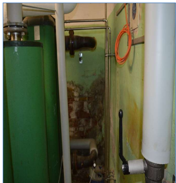
Foto 4: Manglende rørisolering
