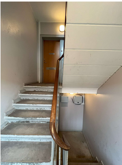
Foto 3: Trappe til stueetage og kælder.
