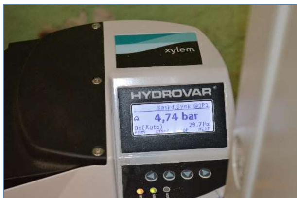
Foto 4: Trykforøger anlæg pumpestryk
