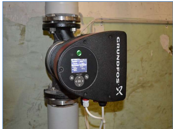
Foto 4: Cirkulationspumpe
